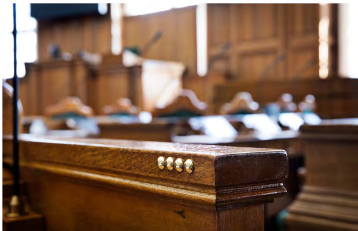
For at forbedre orienteringsmulighederne for mennesker med synsnedsetelse har bordrækkerne fået taktile markeringer, der viser rækkenummeret. De er udført med almindelige møbelsøm i messing. Foto: Ty Stange
